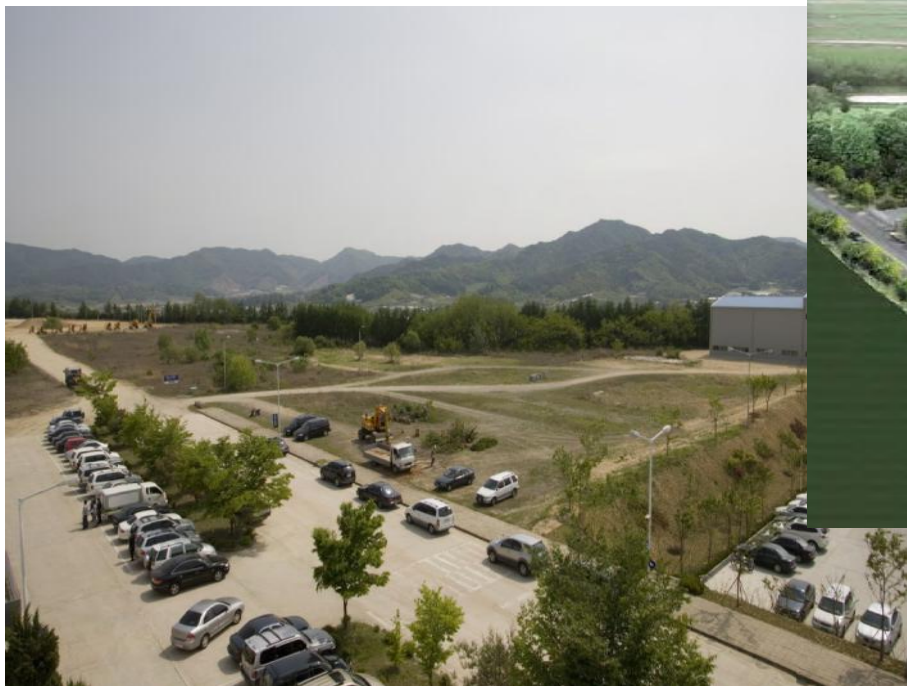
Место для строительства 270 МВт завода по производству солнечных батарей (Еумсеонг, Корея)
